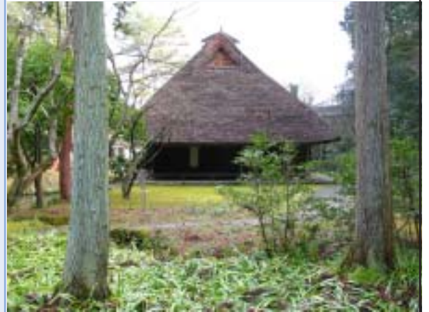
国の重要文化財に指定されている木の花庵（綾部梅松苑）この建物は江戸中期のものとして推定され、摂丹地方の古農家による苦難構造形式手法に特色があり、民家建築として貴重な遺構です。
